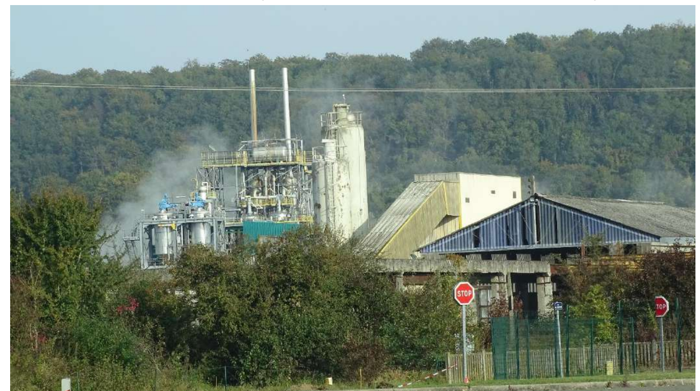
Usine WeylChem, vue depuis le parking au sud-est de l'usine (700 m de l'aire de projet)
