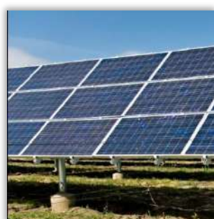
sur plots béton
