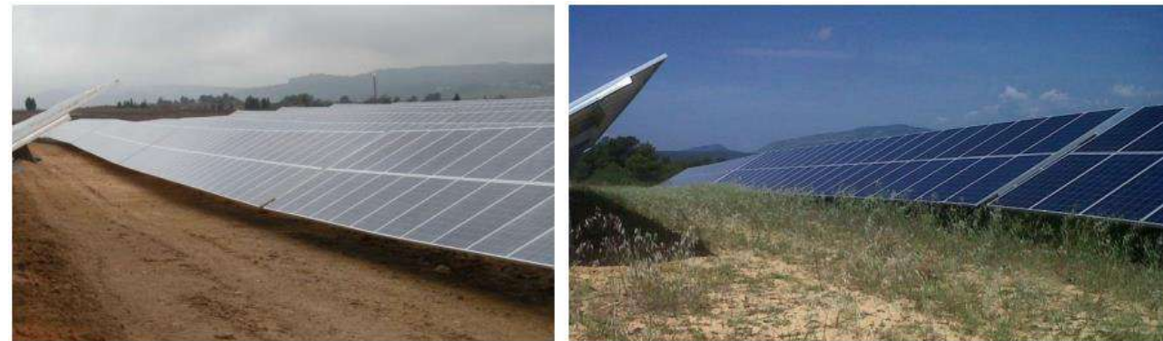
Régénération spontanée de la végétation après travaux
