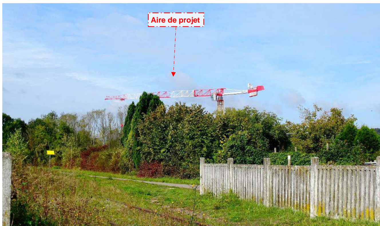
Photographie n° 30 : RD335 , croisement avec l'ancienne voie ferrée (1.2 km au sud-est de l'aire de projet : absence de covisibilité).
