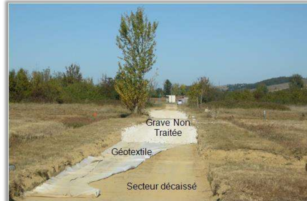
Mise en place d'une voie engins (principale)
