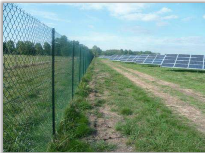
Mise en place de la clôture : pose des ancrages, des piquets et du maillage
