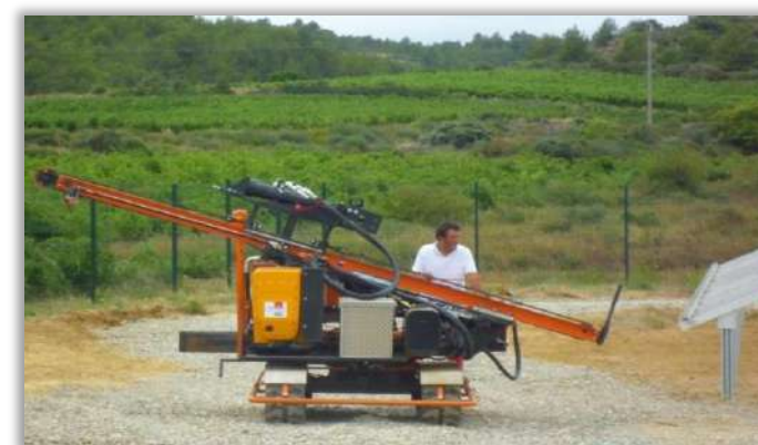
Machine de battage de pieux
