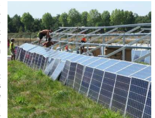
Pose manuelle des modules - Source : LUXEL
