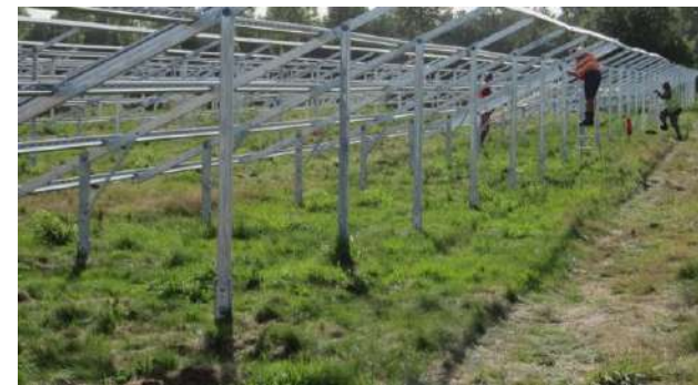
Un faible impact sur le sol et le couvert végétal lors de l'ancrage des pieux et pose de structures
