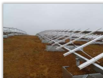
sur supports lestés
