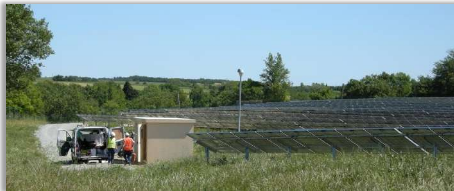
Opération de maintenance
