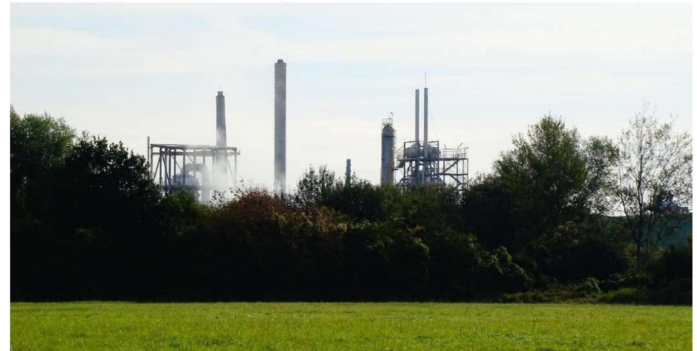
Prairie ouest avec l'usine WeylChem en fond (vue depuis le nord-ouest de l'aire de projet)
